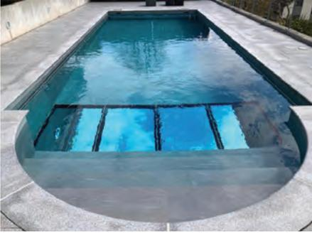
Betonpool mit Unterwasserverglasung.
